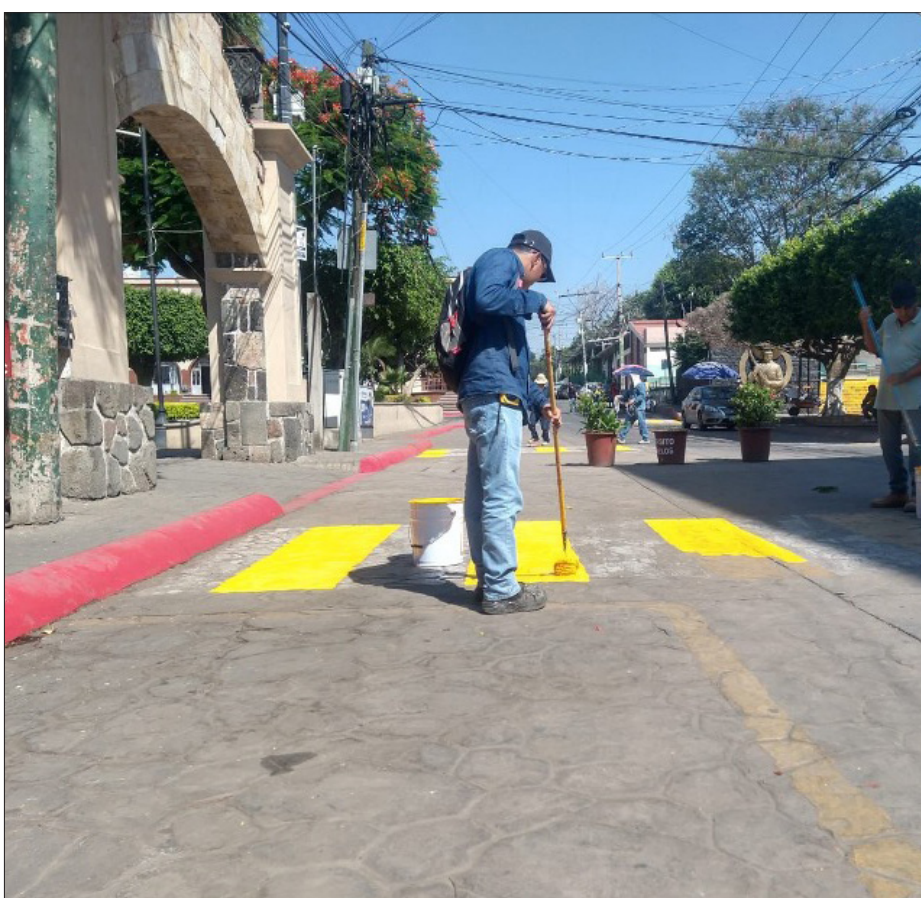
▲ Desde el pasado miércoles 21 de junio, el ayuntamiento de Jiutepec realiza diversas tareas de rehabilitación de vialidades del primer cuadro. / Foto: Ayuntamiento de Jiutepec
