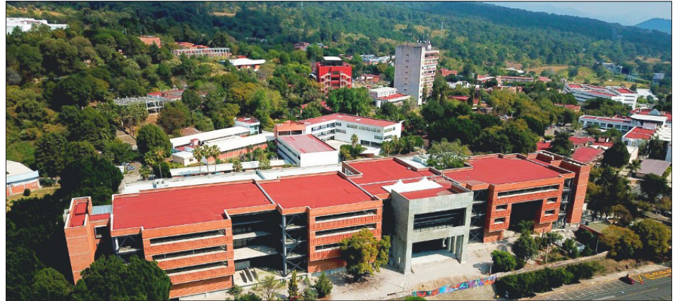
▲ El rector de la UAEM, Gustavo Urquiza, espera dejar iniciadas las obras del nuevo distribuidor vial universitario cuando deje el encargo en noviembre de este año. / Foto: Redes sociales
