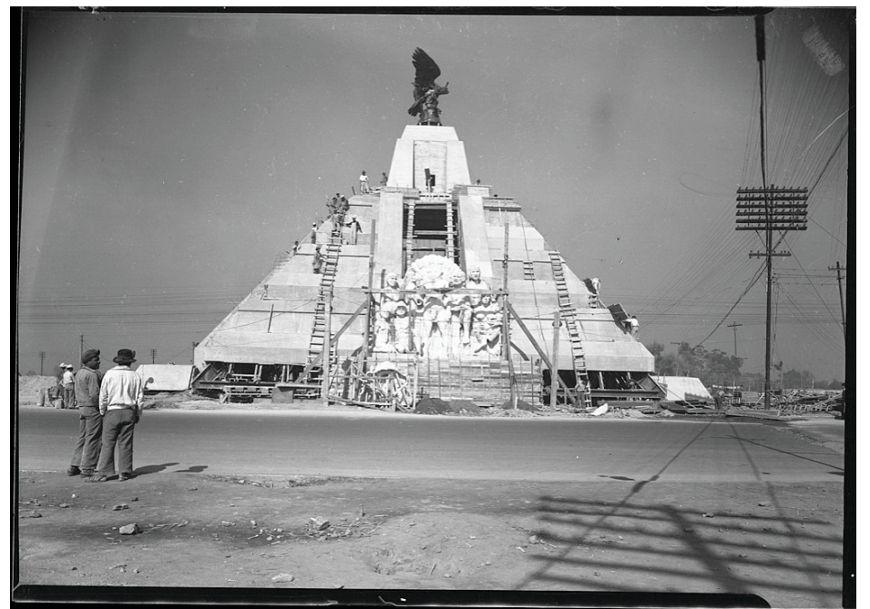
▲ Construcción del Monumento a La Raza.
