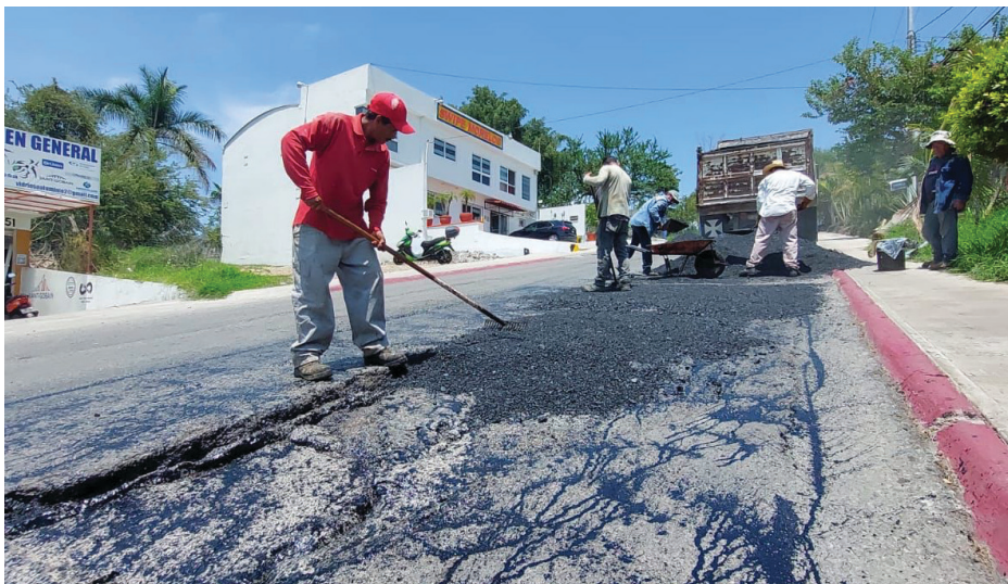
▲ El programa de bacheo 2023 del Gobierno de Jiutepec inició el pasado mes de enero; ya se han utilizado 350 metros cúbicos de mezcla asfáltica. Foto: Ayuntamiento de Jiutepec.
