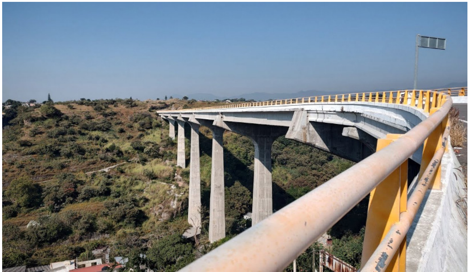
▲ El Distribuidor Vial Apatlaco, "Puente sin fin" / Foto: Redes sociales
