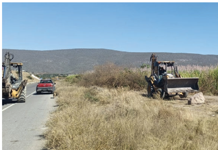
▲ De nuevo se suspendieron las obras de "remediación" en las tierras afectadas por la Autopista S. XXI y los ejidatarios amenazan con reiniciar sus bloqueos. Foto: Hugo Barberi Rico.
