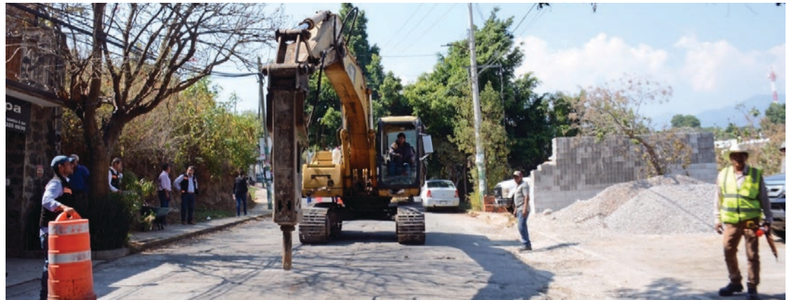
▲ Se dio el banderazo de arranque a la obra de reencarpentamiento de las calles Lomas de Ahuatlán y Gustavo Petriccioli en la colonia Lomas de Ahuatlán que tiene una inversión de más de siete millones pesos. Foto: Ayuntamiento de Cuernavaca.
