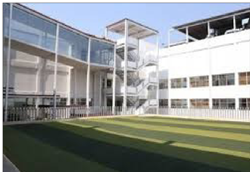
◀ El Hospital General "Dr. Carlos Calero Elorduy" inició operaciones en 2022. Foto: ISSSTE
