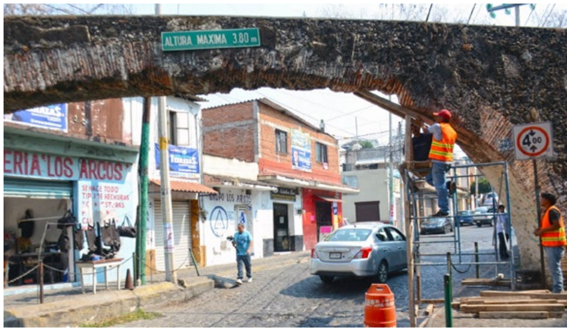
▲ Se invertirán cerca de 75 mil pesos para la construcción de dos arcos metálicos que delimitarán el ancho y altura de los vehículos para prevenir futuras afectaciones. Foto: Ayuntamiento de Cuernavaca.
